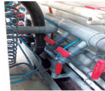
增設處理設備，提升用水循環次數(原始供水再利用循環)
