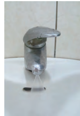
省水器材更換(洗手台加裝省水器)
