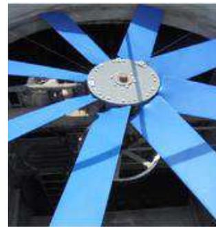
冷卻水塔鋁合扇葉改為 FRP 節能扇
