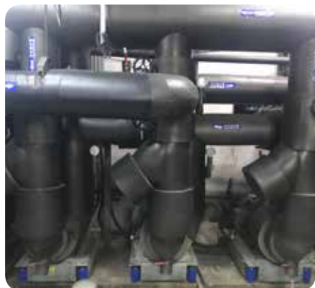
空調冰水管汰換 PE 保溫
